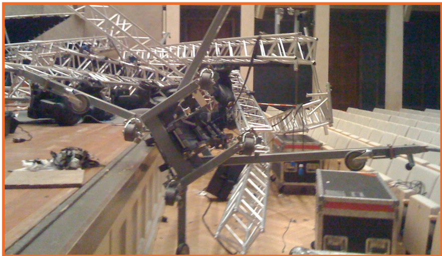
Bei solchen Schäden sollte man gut versichert sein, sonst wird es am Ende extrem teuer
